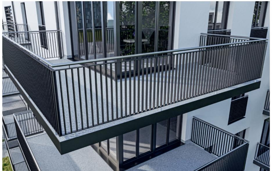
Schnelle und einfache Verarbeitung sind Markenzeichen der hoch leistungsfähigen Balkon Abdichtungssysteme. Denn die Flüssigkunststoffe des Abdichtungsspezialisten basieren auf schnell reaktiven Polymethylmethacrylatharzen (PMMA). Die einzelnen Komponenten der Triflex Systemlösungen härten in weniger als einer Stunde aus, so dass lange Trocknungszeiten entfallen. Dadurch ist ein zügiger Baufortschritt garantiert und die Balkonsanierung innerhalb eines Tages möglich.
