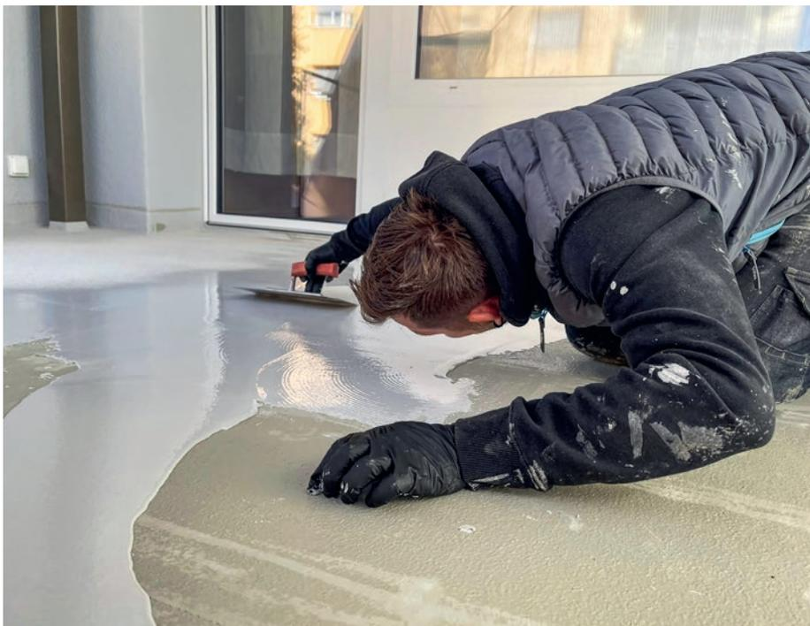
Kalt appliziert, schmiegt sich das Spezialharz an alle Gegebenheit nahtlos an und bezieht auch die Details sicher in die Abdichtung ein.
