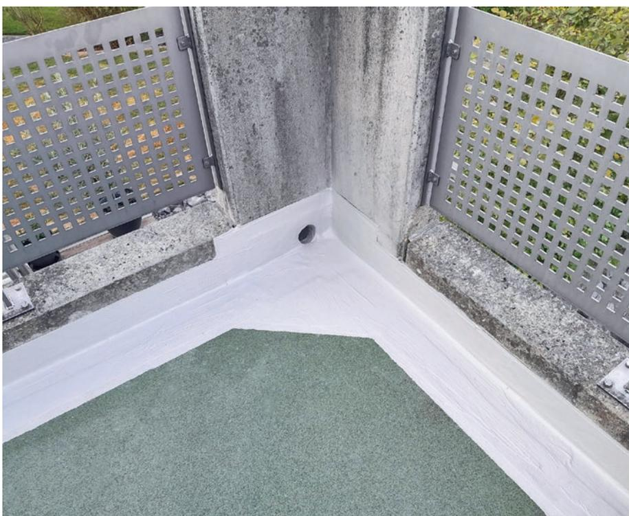
In einem ersten Schritt der Balkonsanierung werden die Details und Flächenanschlüsse abdichtet.
