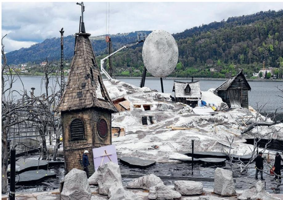
So wurden die Häuser und Steine aus Holz- und Styroporkonstruktionen vorgefertigt, die dann vor Ort mit mineralischem Spachtel unter Einsatz der passenden Geräte das Finish erhielten, um eine perfekte Illusion zu schaffen.
