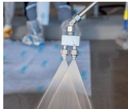
Mittels Sprühpistole erfolgt das Aufbringen präziser, einfacher und um ein Vielfaches schneller. Das Anmischen der Komponenten entfällt, da dies von einem Statikmischer elektronisch gesteuert wird.
