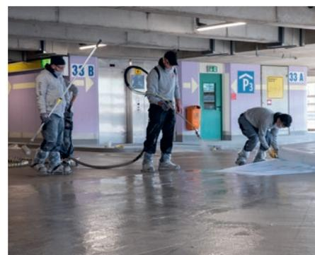
Die Grundierung und die Flächenabdichtung mit Triflex ProPark wurden mit Triflex SAM appliziert.
