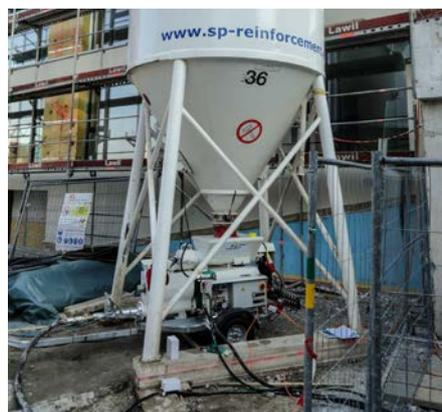
Die PowerPump lässt sich direkt an das Silo anschliessen.
