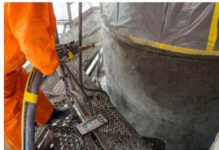
Das ARMO-System verbindet die Bauwerksverstärkung mit der Betoninstandsetzung in einem Arbeitsgang.
