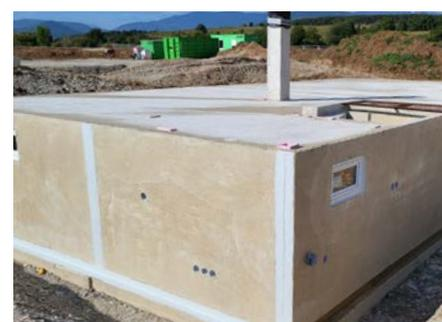
Alsan PMMA 770 TX – die schnelle, dynamische Lösung auf Beton
