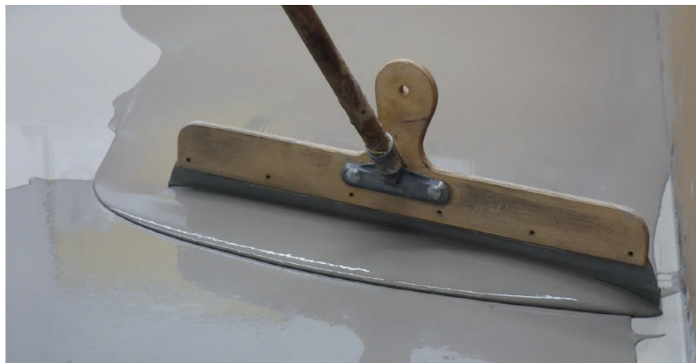
Die neue Epoxy-Hybrid-Beschichtung StoCrete EH 200 kann schnell und einfach appliziert werden und härtet innerhalb kürzester Zeit aus. Zudem sorgt sie für blasenfreie Reaktionsharz-Böden.
