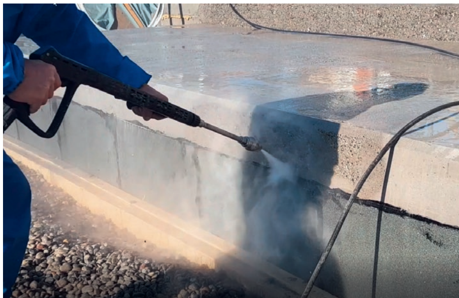
Beispiel: Sanierung Bahnschacht
