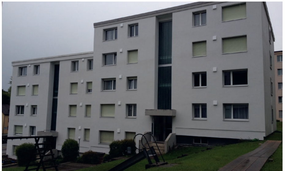
Sanierte Fassade mit Lüfterauslässen
