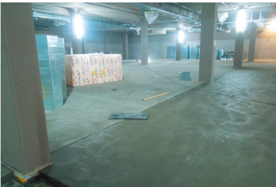
Für den Einbau des Unterlagsbodens und die Plattenarbeiten standen nur rund sechs Wochen zur Verfügung. Für den schwimmenden Überzug in einer Dicke von 80 – 100 mm wurden 80 Tonnen Mörtel verarbeitet.
