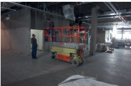
Aufgrund des engen Zeitfensters war eine rasche Belastung sowohl des Unterlagsbodens als auch des fertig verklebten Plattenbelags notwendig. Mit Hebebühnen wurde die Deckeninstallation angebracht.
