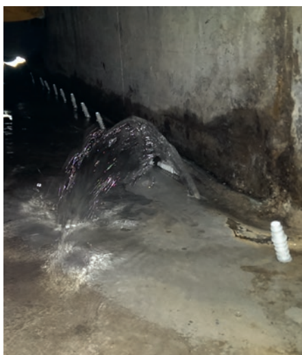
Undichter Boden-Wandanschluss wird mit Schleierinjektion in den Untergrund abgedichtet.
