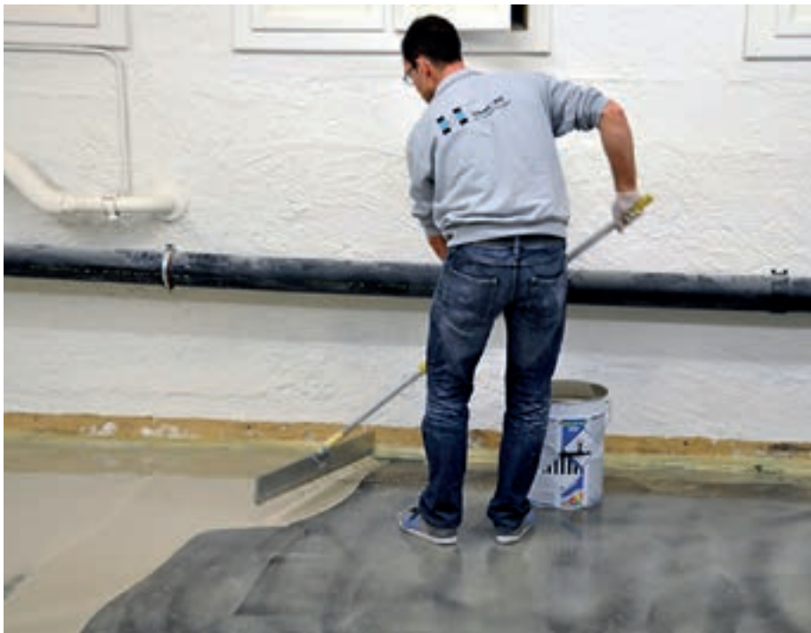
Einsatz einer Rakel zum Erreichen der benötigten Schichtstärke
