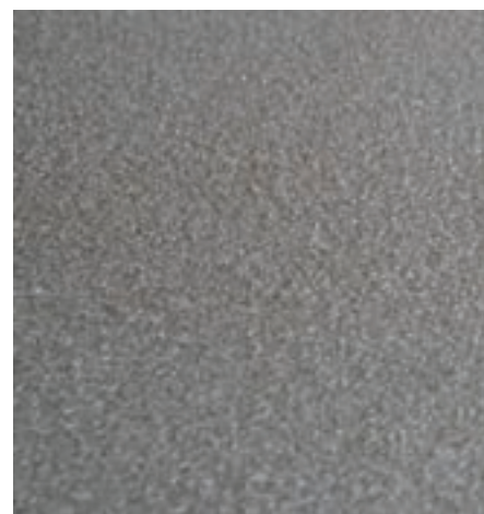
Vollständig im Überschuss abgesandete Oberfläche
