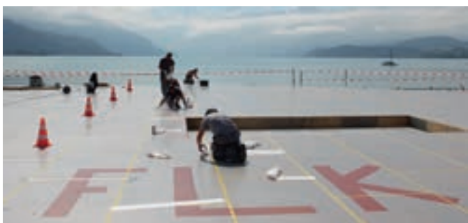
Die Stösse der OSB-Platten werden mit Klebeband abgedichtet und die Vlieszuschnitte vorbereitet.
