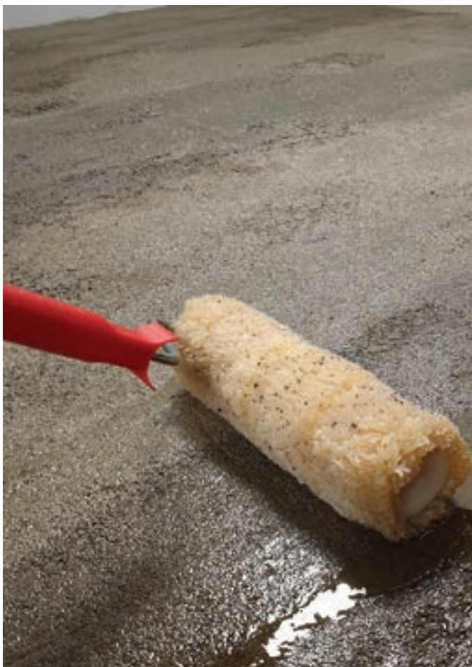
Anwendung von Eco Prim PU 1K Turbo
