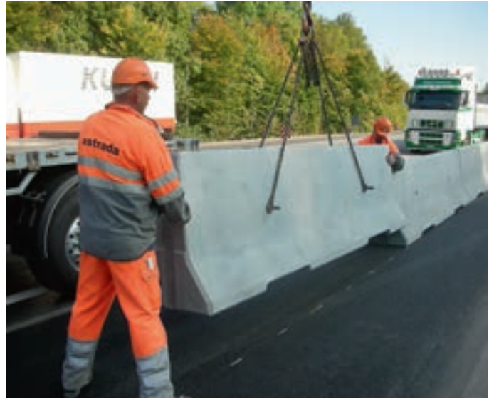
Die Betonelemente werden versetzt, während im Hintergrund der Verkehr über die Stadttangente Bern rollt.
