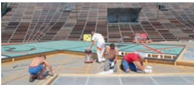
Die vielen Detailanschlüsse werden abgedichtet.
