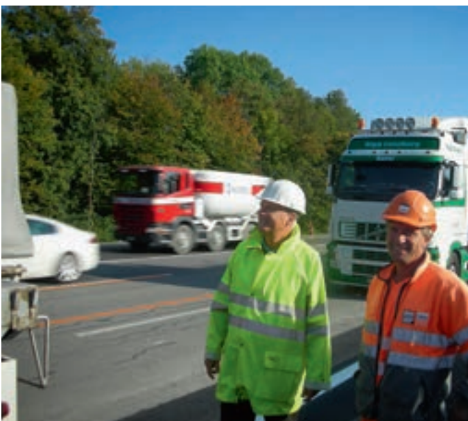
Die angelieferten Betonelemente werden kontrolliert.
