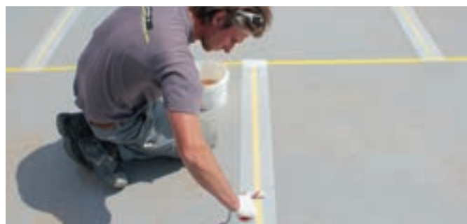
Die Fugenstösse der OSB-Platten werden nahtlos eingebunden.
