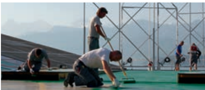
Aufbringen der Wecryl 420 Rollbeschichtung mit Traufel und Roller.
