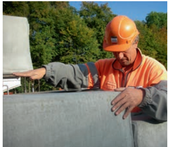
Millimetergenau werden die Betonelemente in der Strassenmitte eingepasst.
