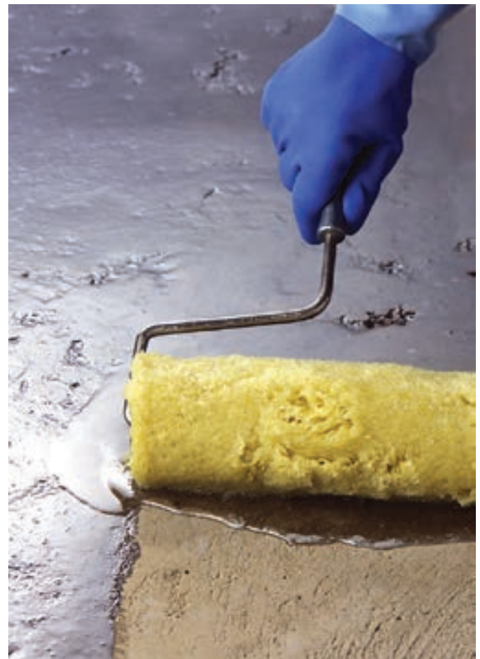
Anwendung von Primer MF
