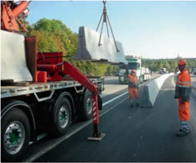
Die Betonelemente werden versetzt, während im Hintergrund der Verkehr über die Stadttangente Bern rollt.
