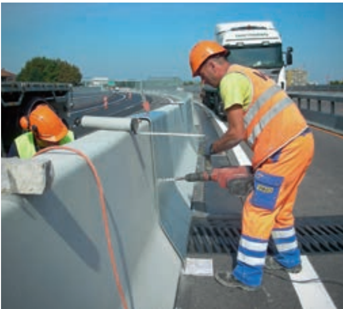
Die Stahlhaube wird an der Dilatation montiert.
