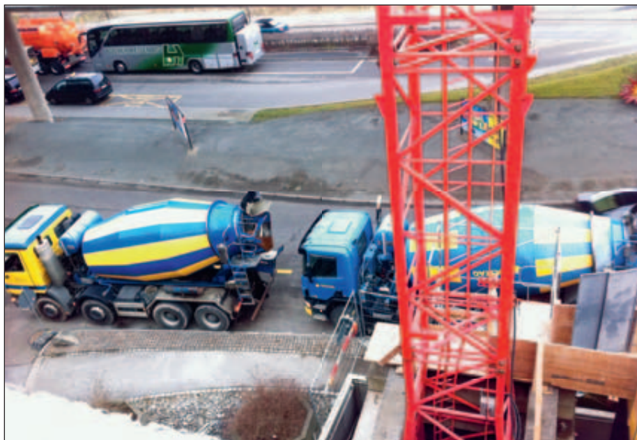
Fahrer bringen SVB-/SCC-Beton mit Körnung 16 mm oder 8 mm direkt zur mobilen Feinbetonpumpe «Concrete Boy 380H».
