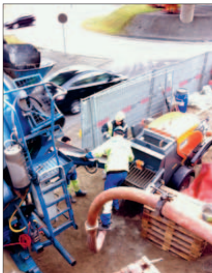
Fahrer bringen SVB-/SCC-Beton mit Körnung 16 mm oder 8 mm direkt zur mobilen Feinbetonpumpe «Concrete Boy 380H».
