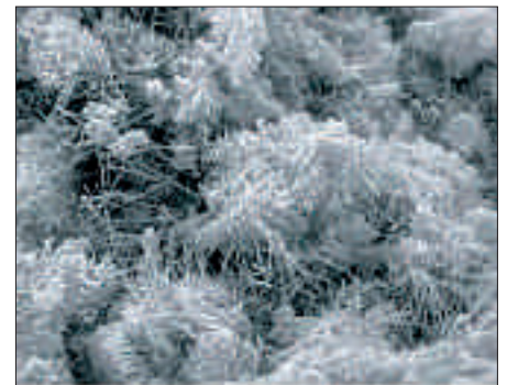
Mit BETOCRETE-C17 (BV) modifizierter Beton wird durch die entstandenen «Fasern» abgedichtet
