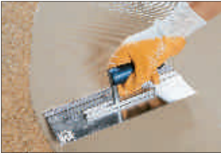
Auftrag der ESD-Beschichtung mit dem Rakel
