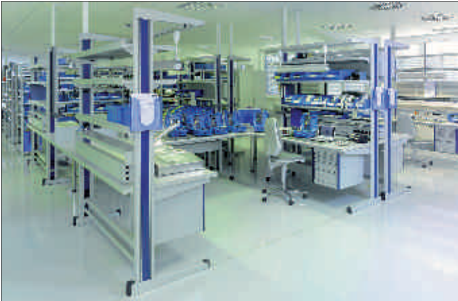
Ein ESD-Boden sorgt hier für die Sicherheit. Elektrostatische Aufladung wird zuverlässig abgeleitet.
