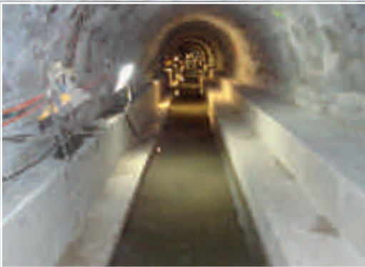
Sanierung Abwasserkanal Hirschengraben Luzern. 280 Meter Trockenwetterrinnen aus Polymerbeton mit eingegossenen Wärmetauschern zur Gewinnung von Wärmeenergie aus dem Abwasser.
