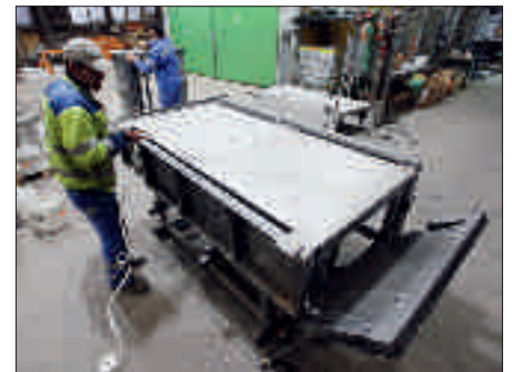
Der Wärmetauscher liegt in der Schalung und wird sorgfältig für das Eingiessen vorbereitet.
