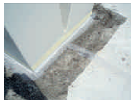
Detail zum Stahlpfeiler
