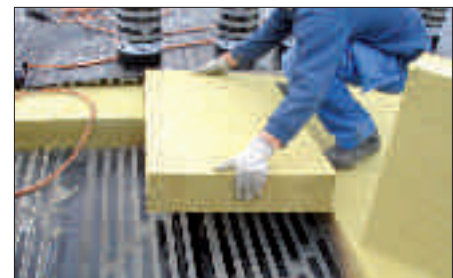
Die Wärmedämmplatten werden mit Hilfe der Activastreifen auf die Dampfbremse geklebt
