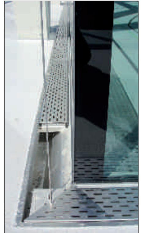
Entwässerungsrinne auf dem Fluchtbalkon
