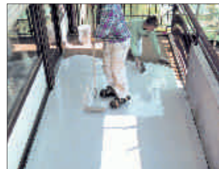
Entlüften mit Stachelwalze
