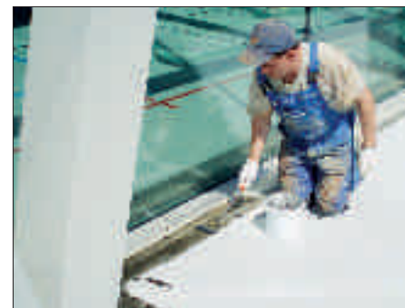
Applikation der Grundierung
