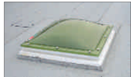
An- und Abschlüsse waren mit besonderer Sorgfalt auszuführen
