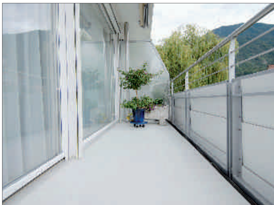
Die Balkonbeschichtung soll unterschiedlichste Anforderungen erfüllen
