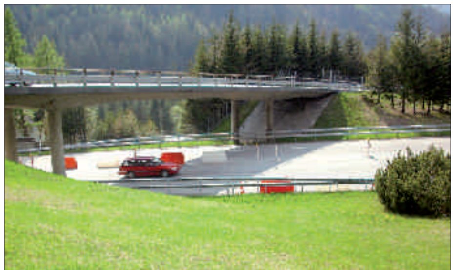
Bild 2: A13, Überführung Pian San Giacomo
