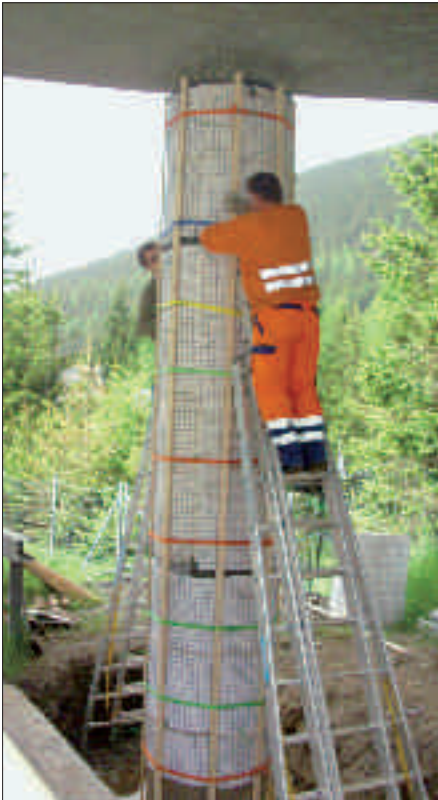
Bild 6: Die Anodenmatte wird zusammen mit einem speziellen Schaumstoff auf die Betonoberfläche montiert
