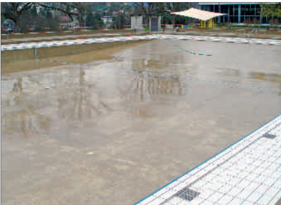
Typische Wartungsfugen. Fuge in Schwimmbecken
