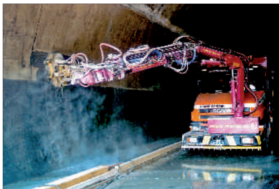
HD-Tunnel-2, Farb- und Beschichtungsentfernung
