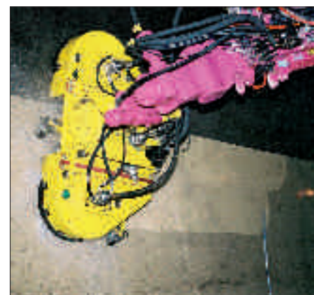
Demarkierung mit Roboter
