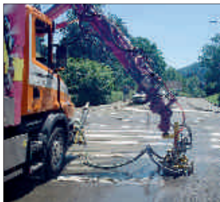
Zementhaut und Rückstände entfernen, Lunkern freilegen
