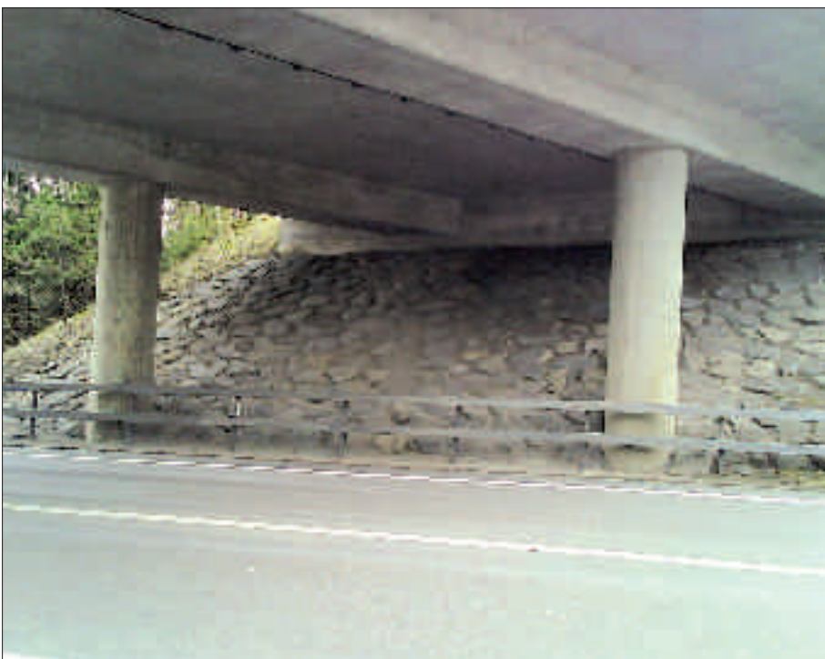
Bild 12: Stützen der Überführung KS 86 an der A53
