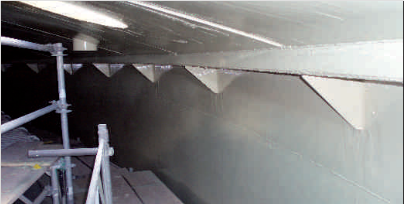
Fertig beschichteter Übergang Dom – Wand
