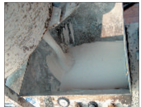
Der fertig gemischte Mörtel wird in den rostfreien Behälter des Vario-Plus eingefüllt.
