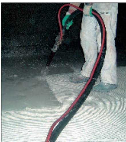
Auftragen des Beschickungsmörtels mit der Spritzpistole
